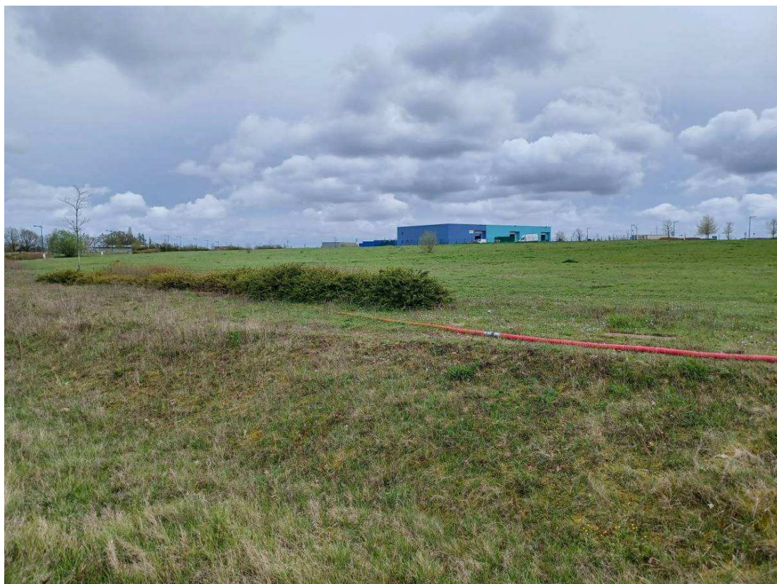
vue 3 site depuis Nord (RD 27)
