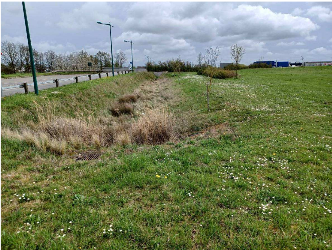
vue 3 site depuis Nord-Est (RD 27)
